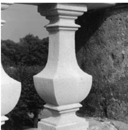
Fehércementtel és homokkal továbbá homokszórással kiváló másolatokat érhetünk el.
