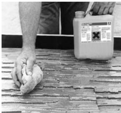
A NOE által forgalmazott NOEplast leválasztószer felvitelét közvetlenül minden egyes betonozás előtt meg kell ismételni!
